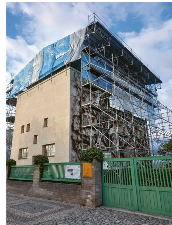
Oprava střechy Müllerovy vily
