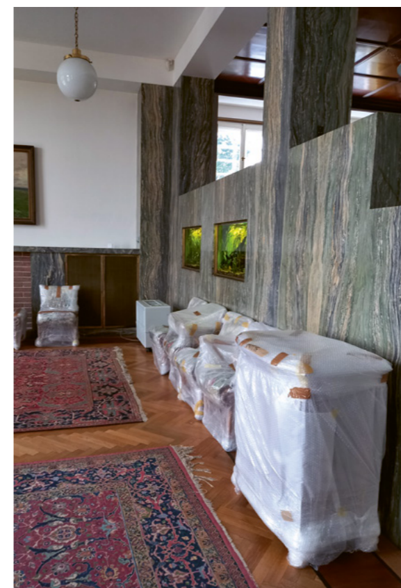
Interiér Müllerovy vily během rekonstrukce
