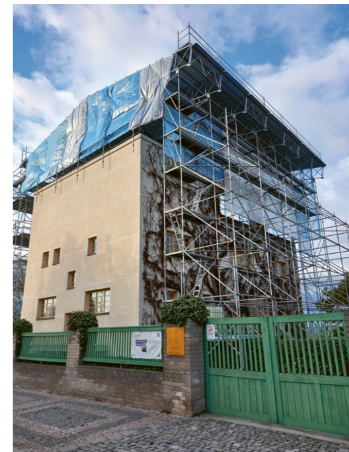
Oprava střechy Müllerovy vily
